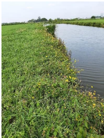
De foto geeft een beeld van de slootkant langs de noordzijde van het perceel. Hij is gemaakt op 18 juli 2023.
