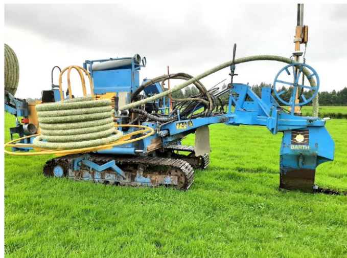
De drains werden sleufloos in de bodem aangelegd door Barth drainage.
