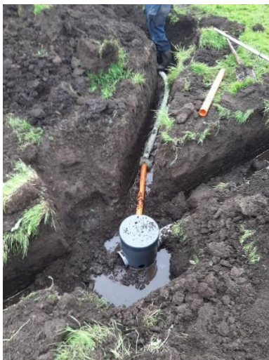
Aansluiting drains op putjes
